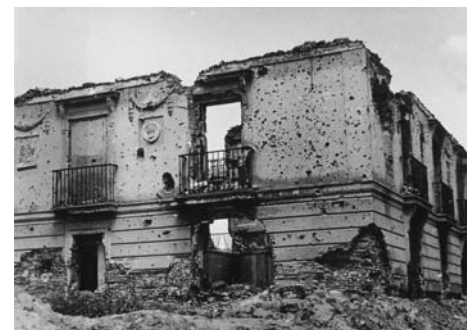
Esquina derecha de la fachada principal.
