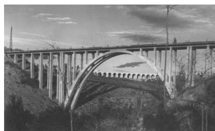
En la foto se puede apreciar el viaducto de los Quince Ojos detrás del puente del Aire. Este viaducto, de 130 metros de longitud por 35 de anchura, sigue permitiendo a los vehículos hoy en día el cruce del arroyo en la carretera de La Coruña. Los arcos más altos, actualmente semienterrados, tenían unos 30 metros de altura y un esbelto trazado, desfigurado al haberse habilitado el espacio inferior para almacenes. Obra de Eduardo Torroja de 1933.
