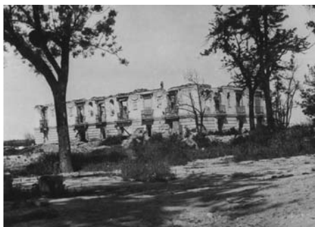
Fachada principal del palacete destruido.
